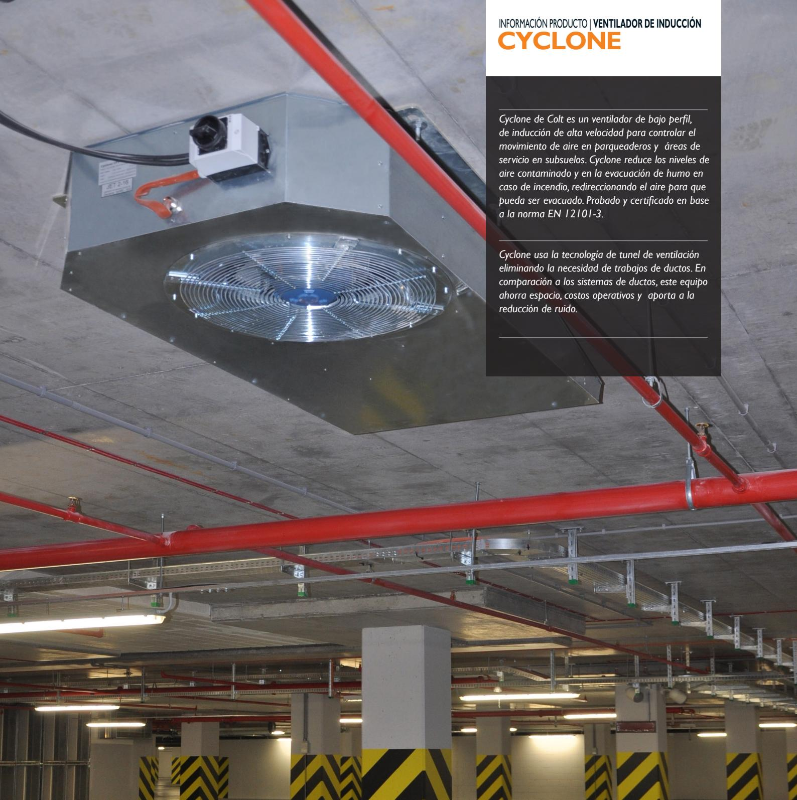
*Cyclone de Colt es un ventilador de bajo perfil, de inducción de alta velocidad para controlar el movimiento de aire en parqueaderos y áreas de servicio en subsuelos. Cyclone reduce los niveles de aire contaminado y en la evacuación de humo en caso de incendio, redireccionando el aire para que pueda ser evacuado. Probado y certificado en base a la norma EN 12101-3.*
